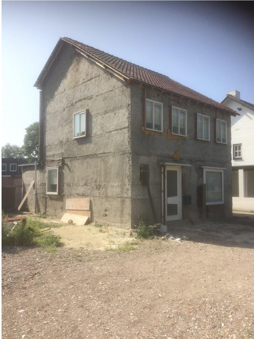
Woning aan de Kruisstraat in Zeelst
