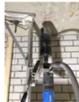
Foto: betonboringen luyksgestel
